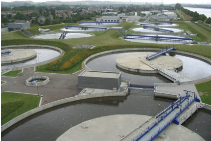
Station d'épuration des eaux usées de Oupeye, en Belgique. ©Wikimédia Commons
